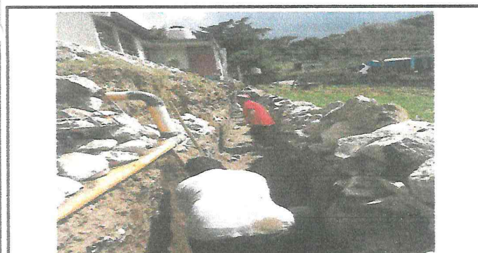
Foto 5: cabando surca para iniciar a fundir
