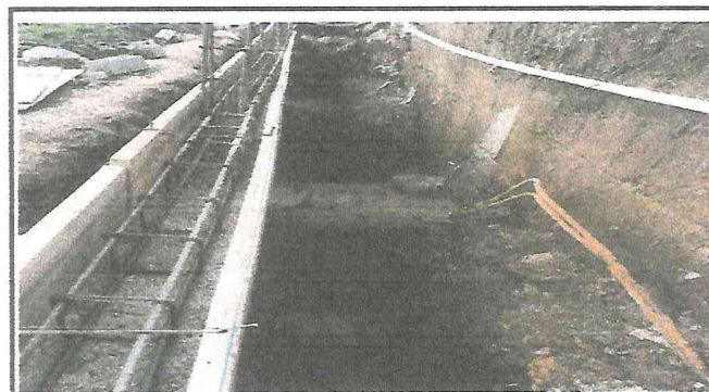
Foto 6: Fundición de bases
